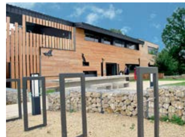
Visuel BD Architectes
